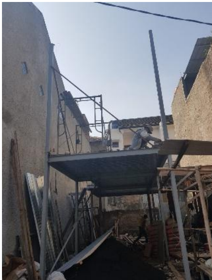
Gambar 1: Rangka bangunan dengan modul jarak 3 x 3 m
