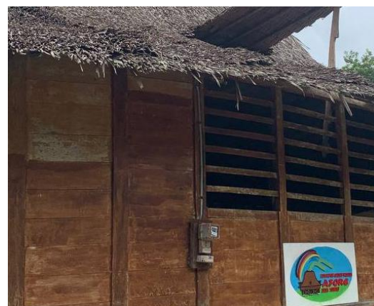
Gambar 13. Struktur Dinding Omo Osali Mbowo
