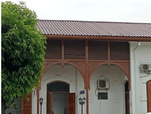
Gambar 8: Elemen Kisi-kisi pada Selasar Fasad Bangunan Stasiun Kereta Api Binjai
