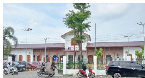
Gambar 3: Fasad Bangunan Stasiun Kereta Api Binjai
