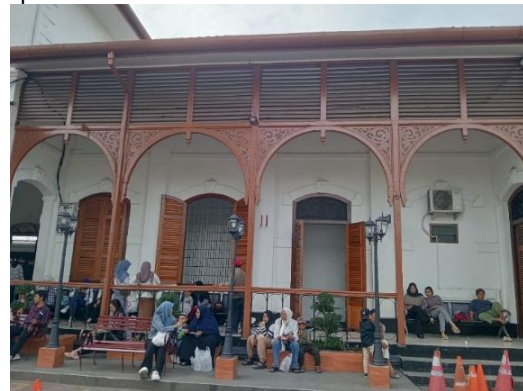
Gambar 6: Elemen Lengkung pada Selasar Fasad Bangunan Stasiun Kereta Api Binjai
